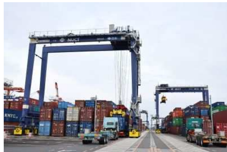
T3で稼働する遠隔操作RTG
